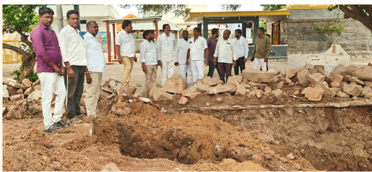
ప్రహరీ గోడ నిర్మాణం పనులను పరిశీలిస్తున్న కృష్ణారావు
